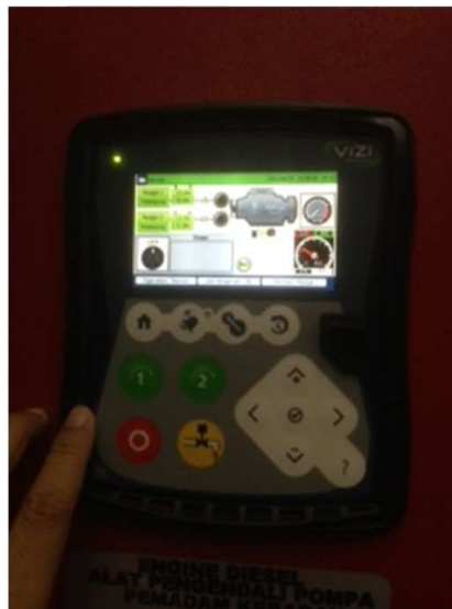
Gambar 17 — Panel kontroler diesel modern berbasis layar sentuh, menampilkan status mesin, tekanan, dan mode operasi (auto/manual/test).
